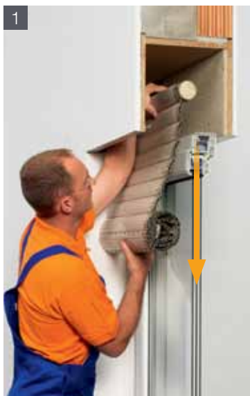
1 Alten Rollladen aus Kasten entfernen!
