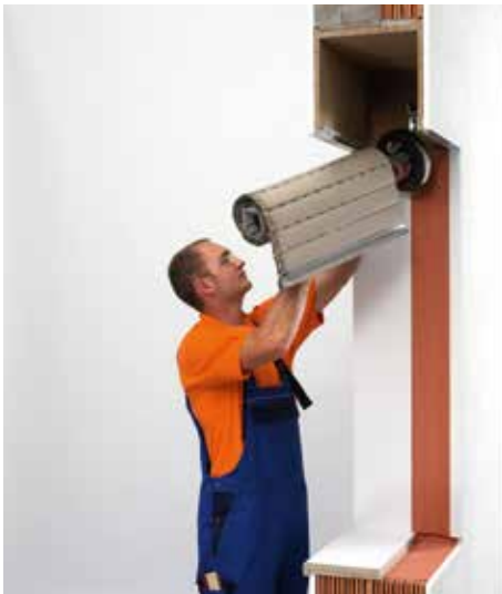
Alten Rollladen aus dem Kasten entfernen.
