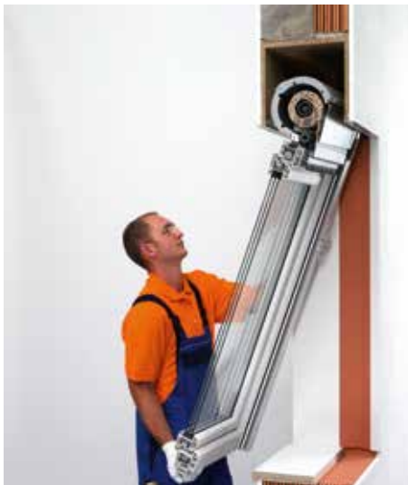
Fenster mit TERMO einsetzen.
